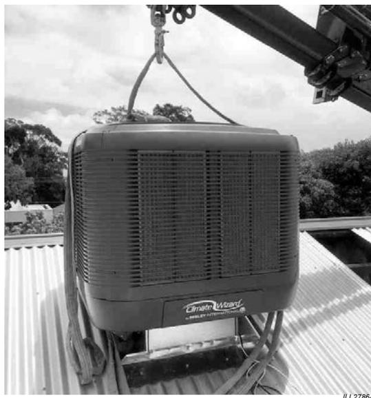
Fixation du refroidisseur sur la transition de la conduite d'évacuation à l'aide des vis fournies. Il faut au total douze (12) vis. Utilisez uniquement les vis fournies.
