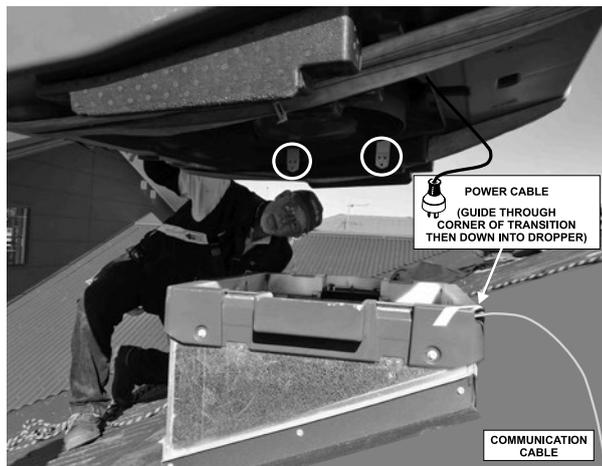
Identifiez les attaches blanches de la transition de la conduite d'évacuation qui font saillie par rapport au réservoir. Ces attaches sont évasées vers l'extérieur et doivent se placer à l'extérieur des bords de la transition de la conduite d'évacuation lors de l'abaissement du refroidisseur.
